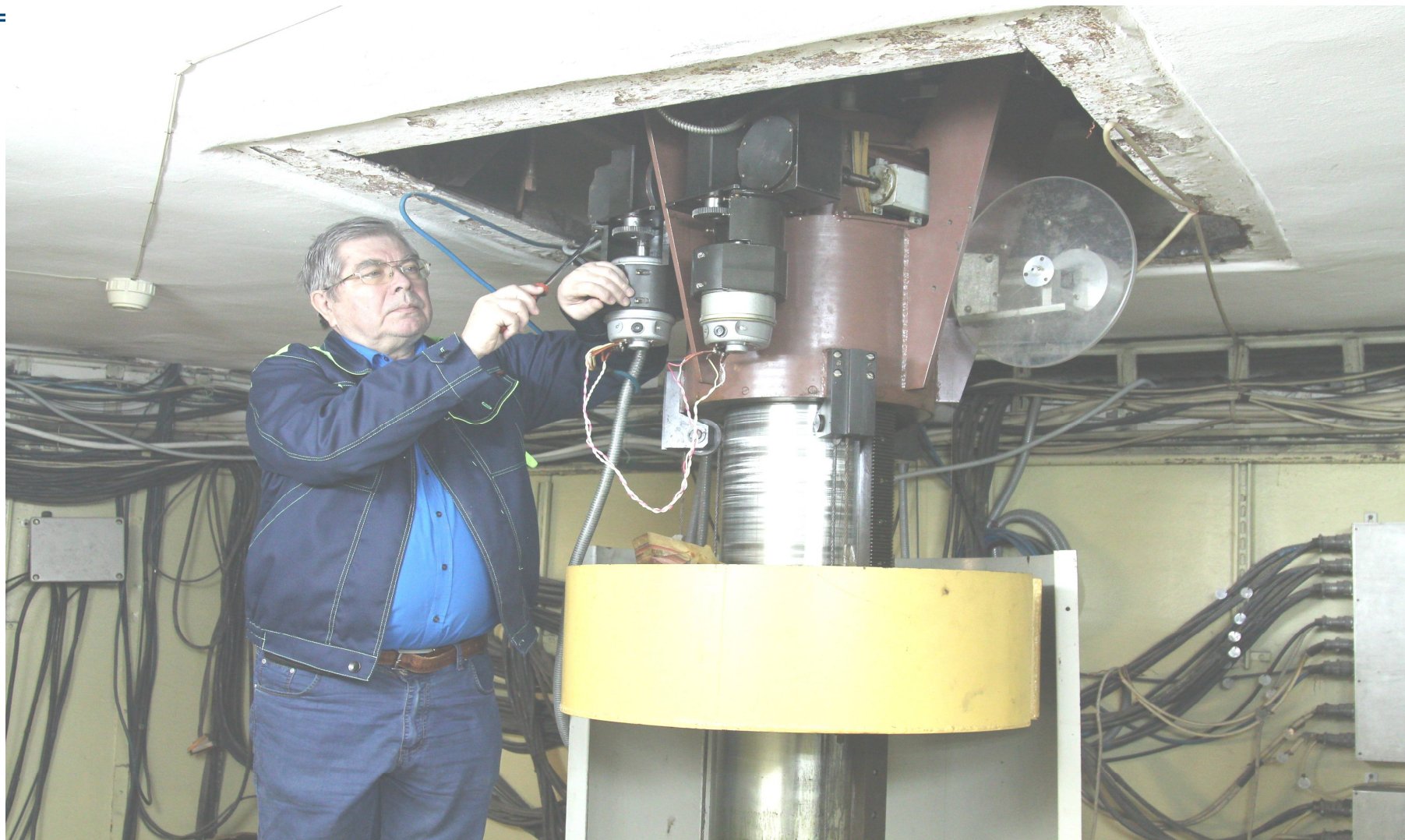
Наладка электро – механического оборудования одной из лучевых установок – Кресла - позиционера (подвальный этаж)
