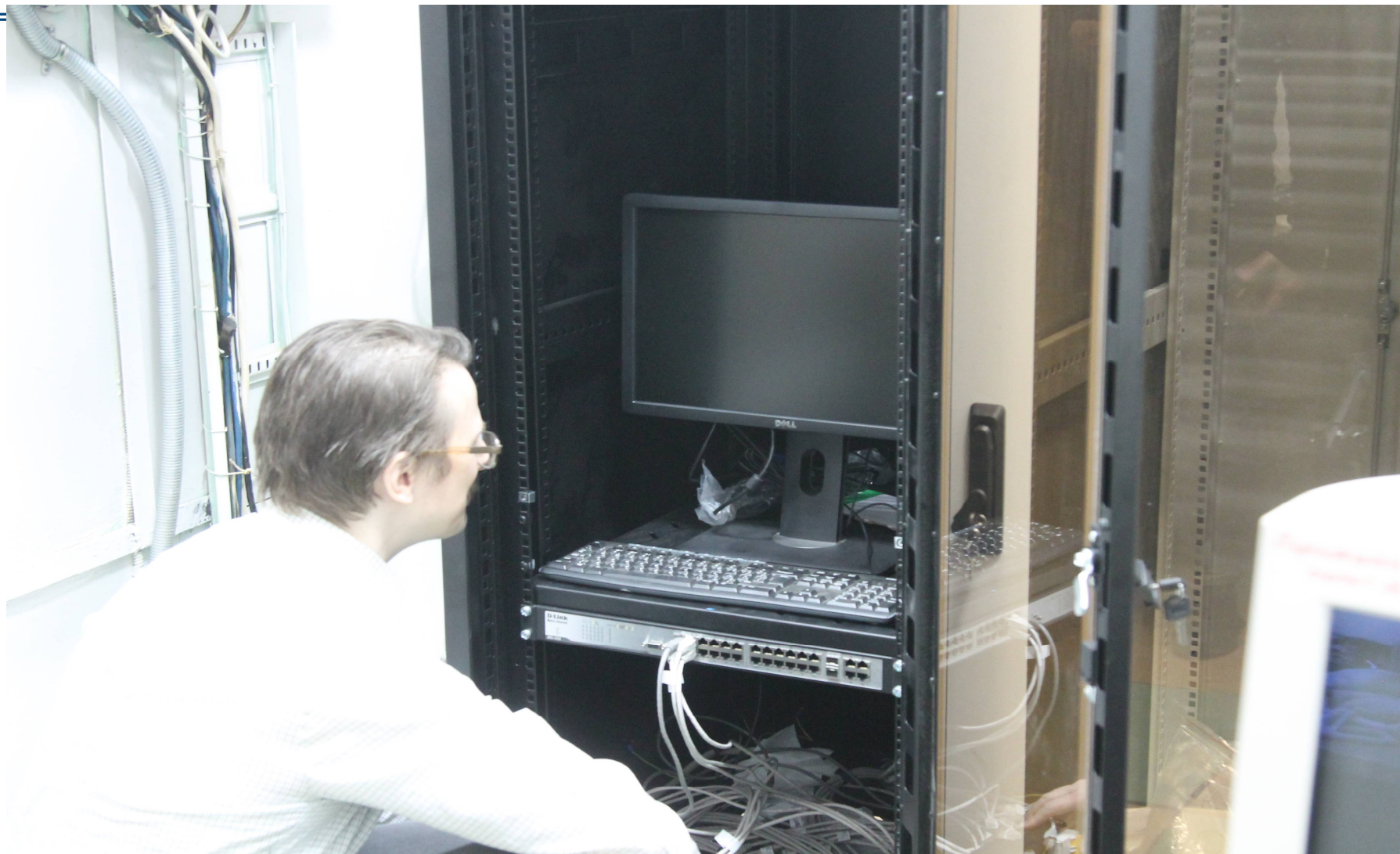
Телекоммуникационная стойка с оборудованием локальной вычислительной сети
